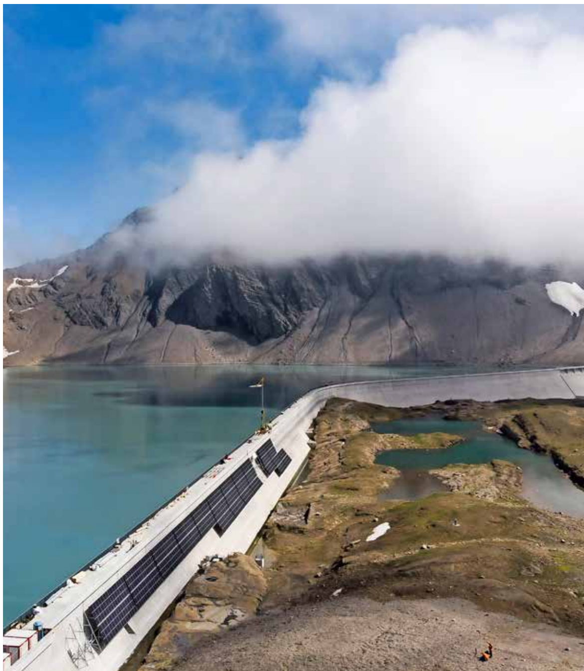
Die Axpo geht beim Ausbau von Solarstrom mit gutem Beispiel voran. Blick auf die Axpo-Baustelle «Alpin Solar» an der Muttsee-Staumauer in Linthal.
